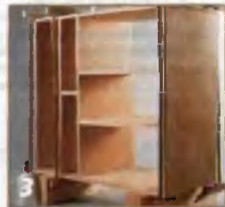
3 Присоединяя боковины, необходимо контролировать прямоугольность конструкции.
