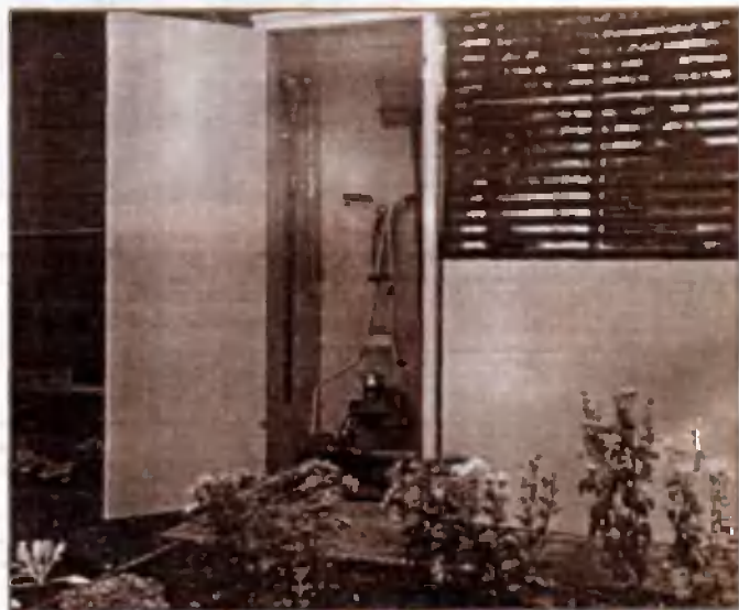
Пол хранилища и мощеная площадка — на одном уровне. Это позволяет такой инвентарь, как газонокосилку, просто вкатывать.
